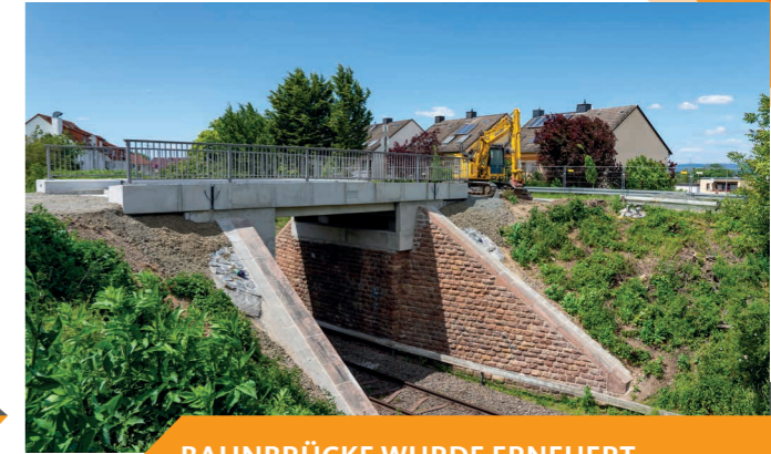
BAHNBRÜCKE WURDE ERNEUERT
