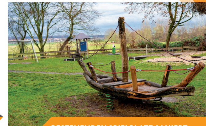
BESTEHENDEN SPIELPLATZ SANIERT
