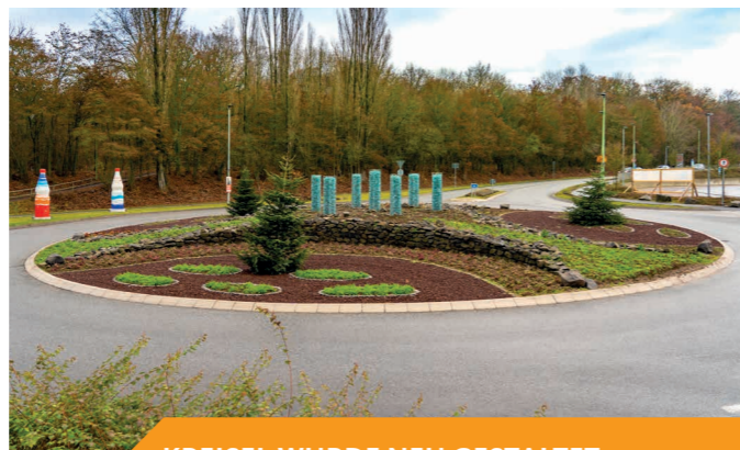
KREISEL WURDE NEU GESTALTET
